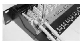
Serrez les vis au boîtier métallique pour attacher solidement deux gaines de câbles en même temps.
